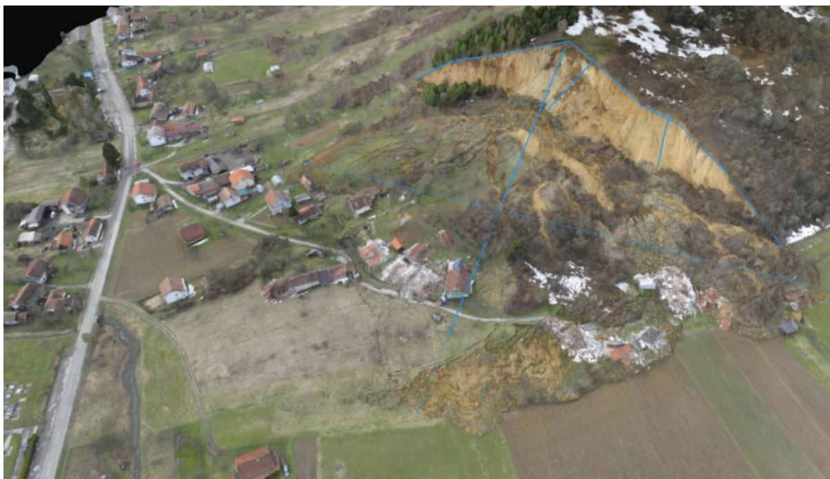
3D model klizišta izrađen temeljem snimke iz zraka rezolucije 10 cm (HGI 14.03.2018)
